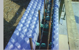
Module ohne Kleber aufsetzen
