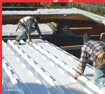
zwei Personen reichen für die gesamte Deckenverlegung
