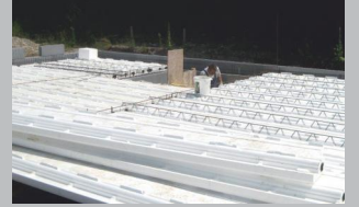
Bewehrung mit System Gitter-
