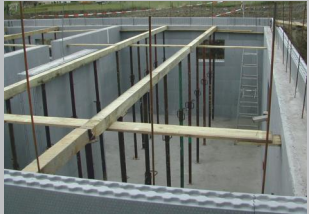
Unterstellung alle 1,25 bis 1,50 m
