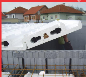
die exakte und trotzdem einfache Verlegung mit Wolf Technik vermeidet Stossfugen
