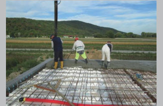
betonieren der Fläche
